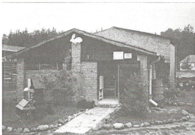
Fot. 2. Budynek królikarni w Wandzinie
