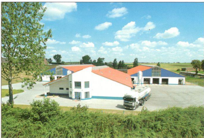
SK Dobrzyńewo – obora wolnostanowiskowa w Mrozowie, widok ogólny (fot. A. Klimek)
