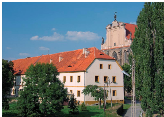
Fot. 1. Siedziba Zarządu OHZ w Kamieńcu Ząbkowickim Sp. z o.o. – zaadaptowany obiekt poklasztorny (fot. P. Blicharski)
