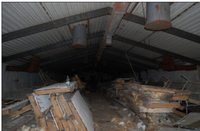
Fot. 1. Stan przed remontem
