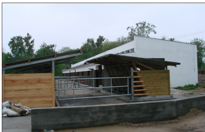
Fot. 3. Adaptacja wychowalni buhajków na oborę wolnostanowiskową – widoczne zewnętrzne boksy legowiskowe (fot. Archiwum SK „Nowe Jankowice”)
