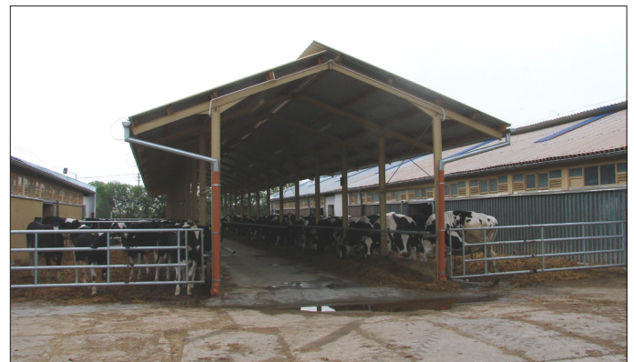
Fot. 4. Zmodernizowane jałowniki z zadaszonymi stołami paszowymi (fot. Archiwum SK Nowe Jankowice)
