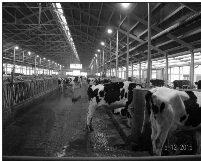
Fot. 2. Czyste korytarze jako efekt częstego usuwania odchodów zgarniakiem delta (fot. J.L. Jugowar)
